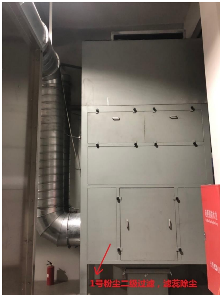
图 3.1-3 喷塑线喷塑粉尘处理设施现场图
