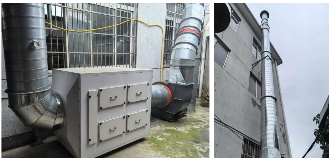
图 3.1-2 活性炭吸附装置及对应排气筒
