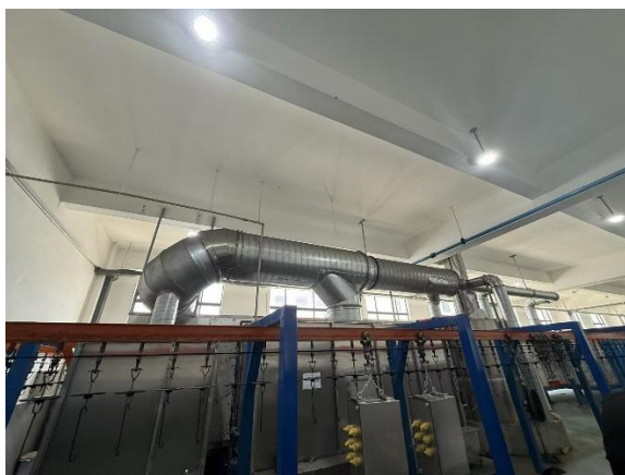
油性漆喷漆线及对应废气收集管道
