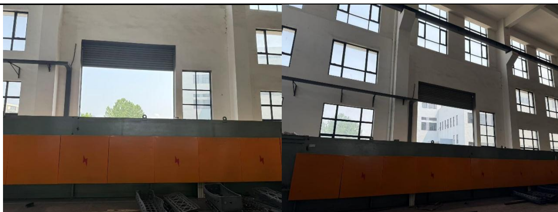
焊接车间通风措施
