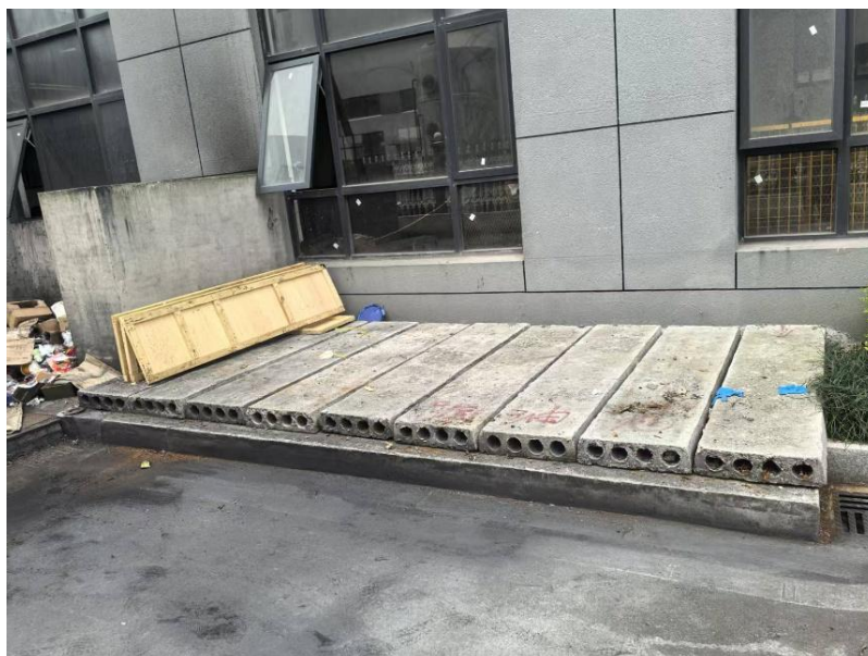
厂区沉淀池（尺寸： 2.8\text{m} \times 2\text{m} \times 2\text{m} ）
