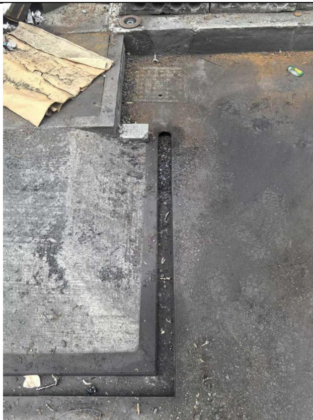
一般固废仓库内导流沟
